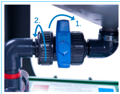
Bild. 117 Stänga avstängningskranen och lossa huvmuttern.
