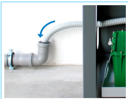
Bild. 40 Anslut avloppsslangen till avloppssystemet
