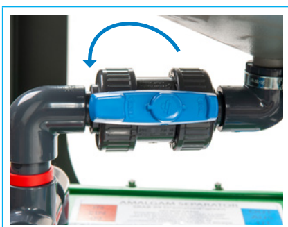
Bild. 105 Öppna avstängningskranen
